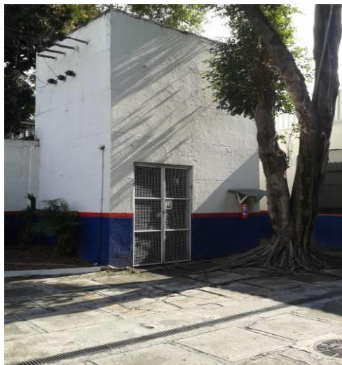
Figura 4: Subestação de energia
