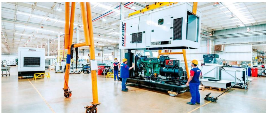
Figura 10: Vista interna do Pavilhão Industrial
