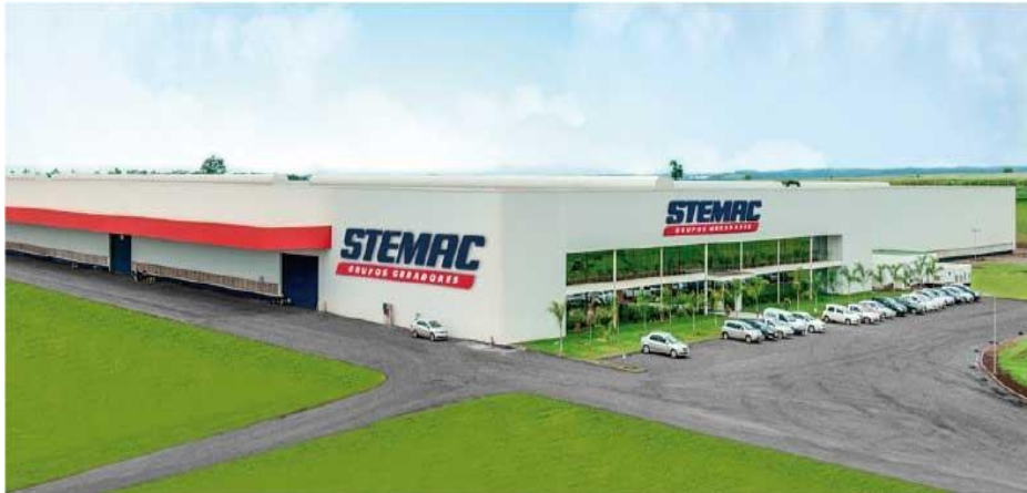
Figura 8: Vista geral do Pavilhão Industrial
